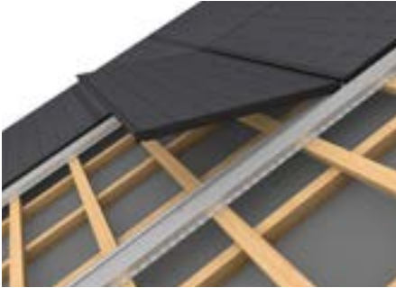
4 Die einzelnen Solarmodule lassen sich einfach einklinken...
