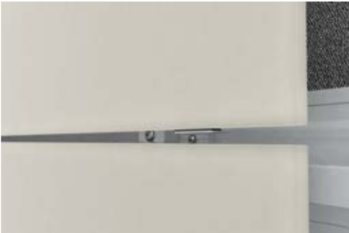
3 Modul provisorisch sichern und justieren, +/- 3mm auch nach Montage möglich.
