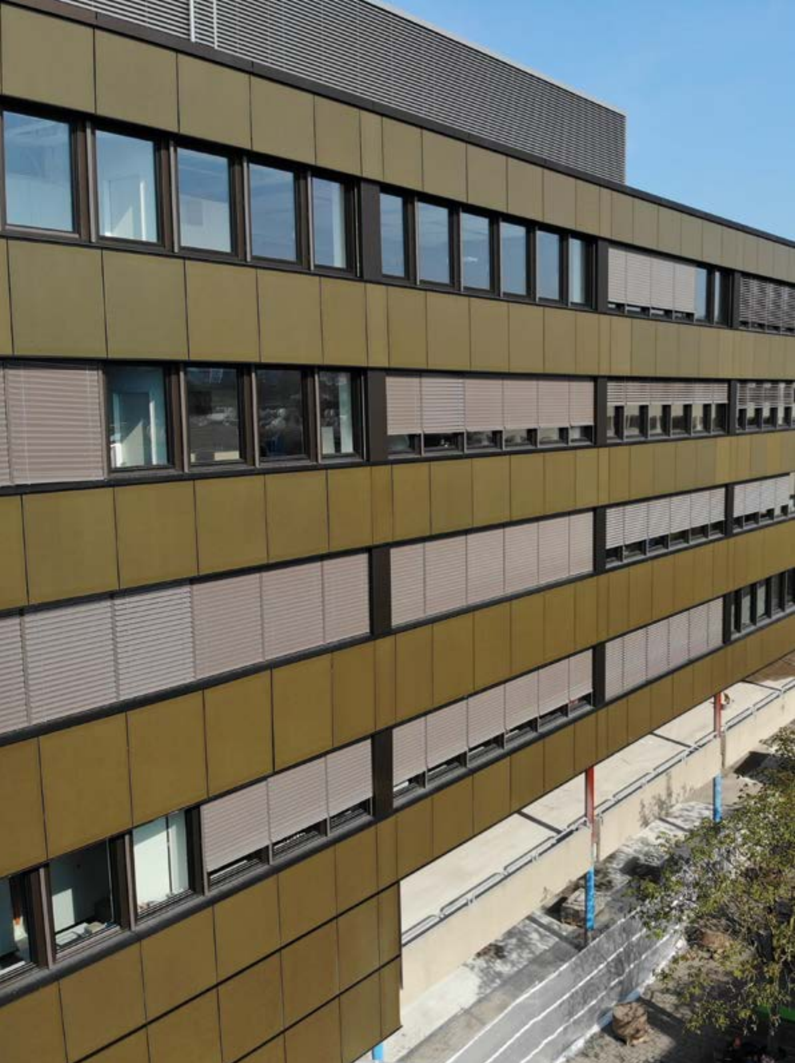
▲ Coop Letzipark Zürich | Solarfassade mit Modulen in Sonderfarbe
